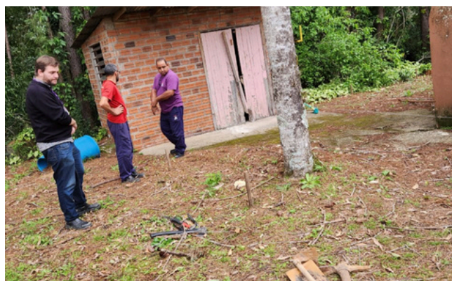
Construção de Canil em parceria com a Empresa Artecola.
